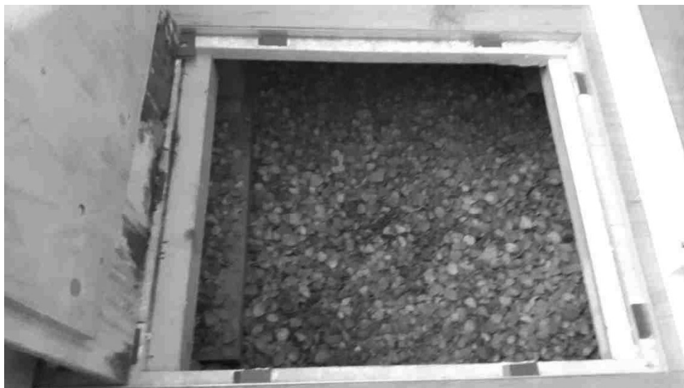
Foto 4: kruipluik in de slaapkamer t.h.v. voorgevel, bodemafluiting is voorzien van schelpen.
